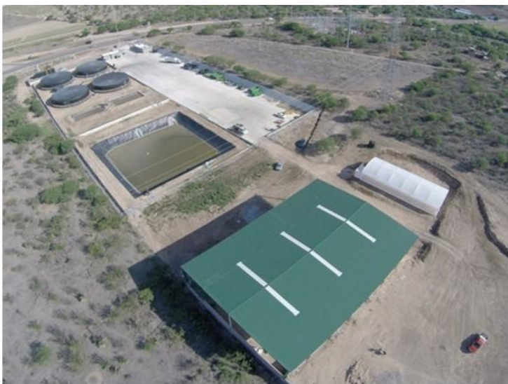
Figura 3. Central de generación de energía eléctrica con biomasa de nopal CZZ Calvillo.
