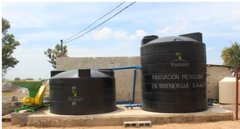
Figura 4. Modulo de biodigestión para generar 12kwd
