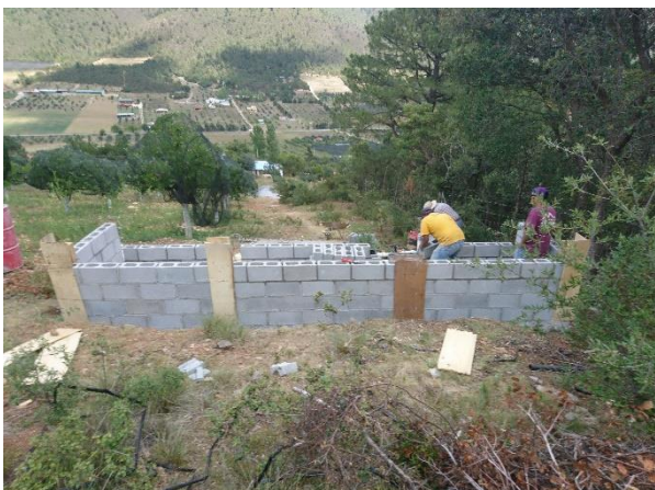
Figura 3. Construcción de Pila de vermicomposta rural.
