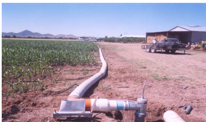
Figura 2. Sistema de riego por goteo de baja presión (LPS) al inicio de su operación.
